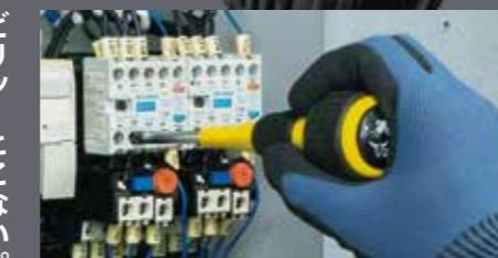
通常の貫通ドライバーとは違い、座金に金属を使っていないため電気を通さない。そのため電気工事の現場でも使用可能。
